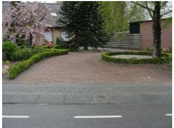
Sanering Sprang Capelle, vanuit één zijde van de weg
